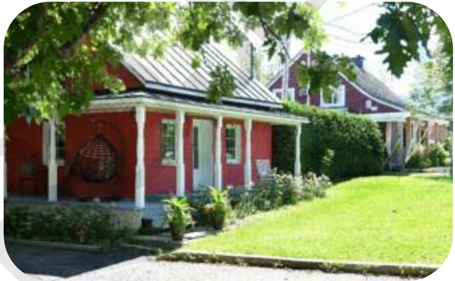
Figure 14 – Bâtiments présentant un intérêt patrimonial dans le noyau villageois
